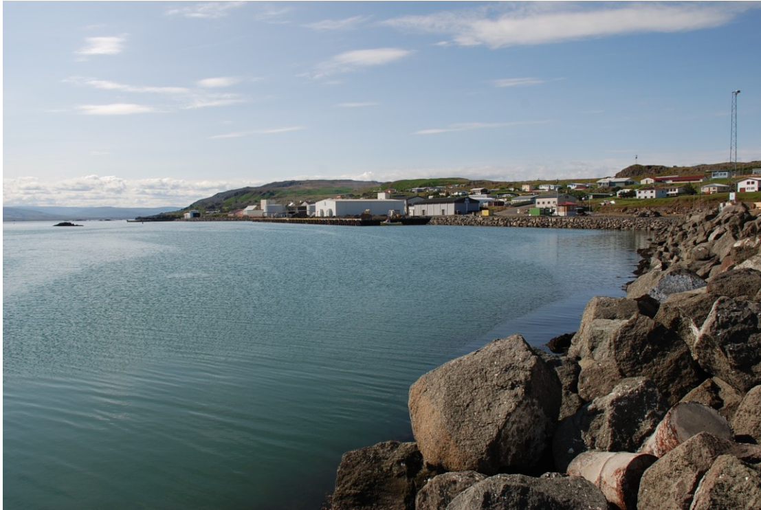
Mynd 1. Horft frá Ásgarðsbryggju til suðurs yfir hafnarsvæðið.
