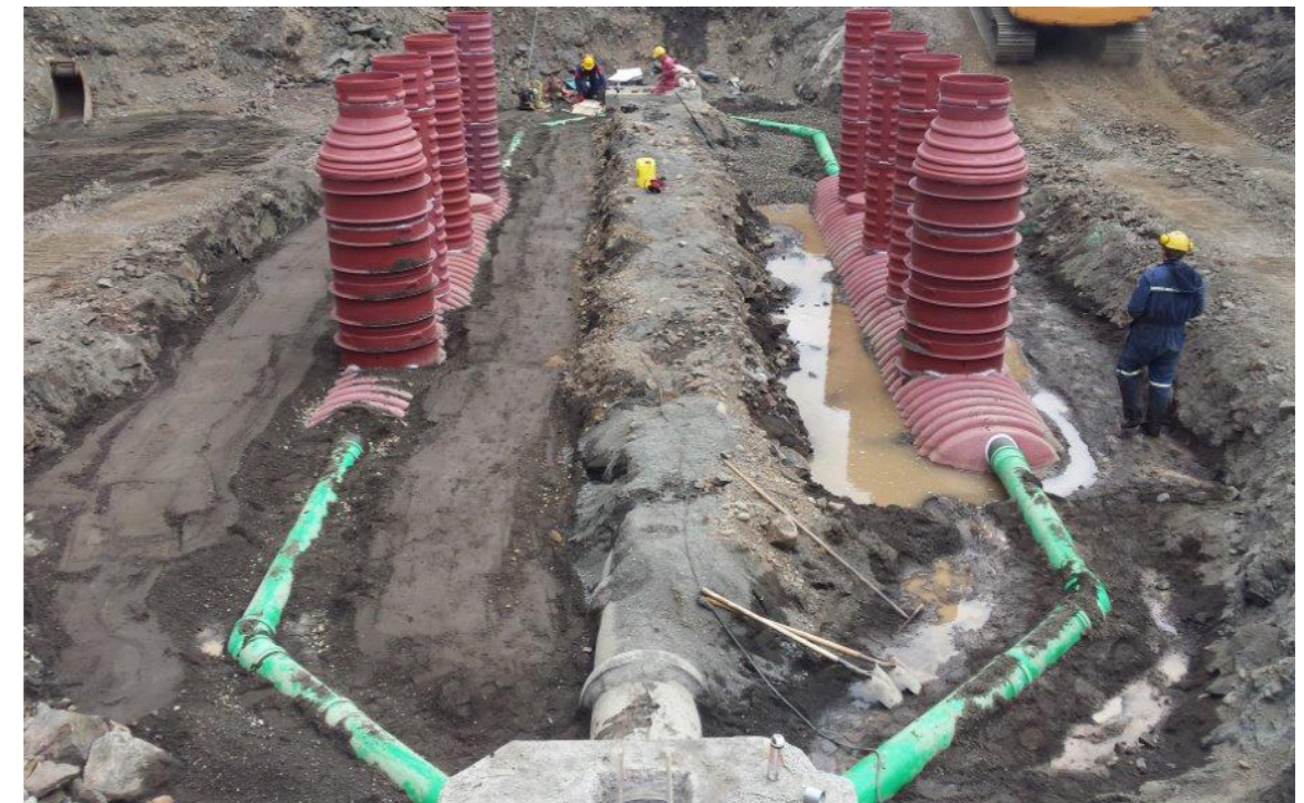
Árið 2014 var komið fyrir tveimur 17 þúsund lítra setþróm fyrir á aðalfrárennslistofn frá verksmiðjunni
