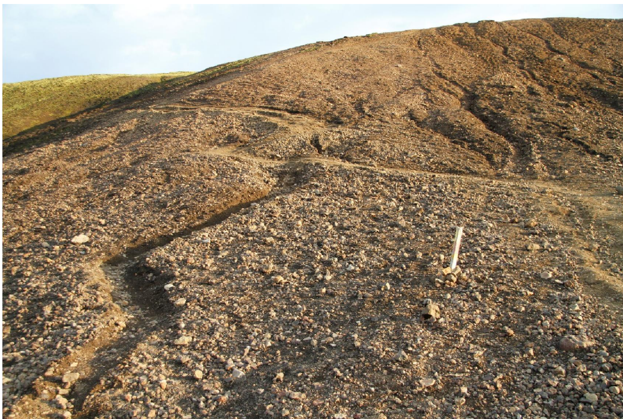
Mynd 3.25: Tvöfaldur stígur í brekku með lausu blönduðu efni (Mynd 3472).
