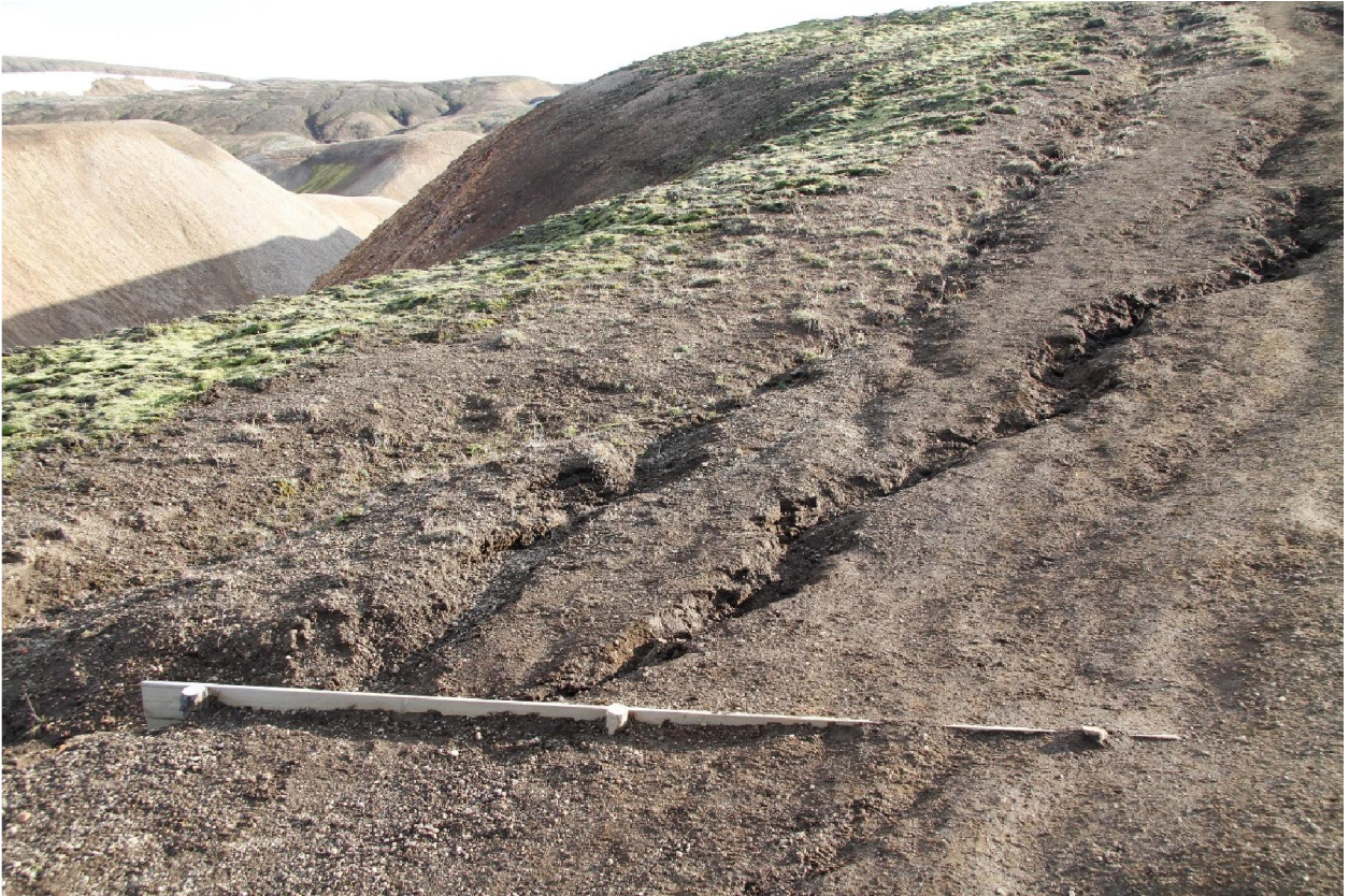
Mynd 3.16: Viðgerð sem ekki nær að stöðva vatnsrof eftir stígunum (Mynd 3386).
