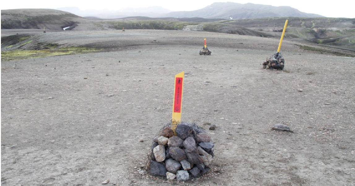
Mynd 3.1: Vegagerðarstikur úr plasti og grjótkúluundirstöður (Mynd 3436).
