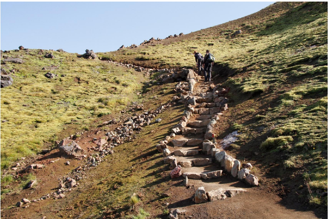
Mynd 3.11: Dæmi um góðar tröppur en átroðning utan stígs. Stígur of mjór fyrir mætingar. (Mynd 3330).
