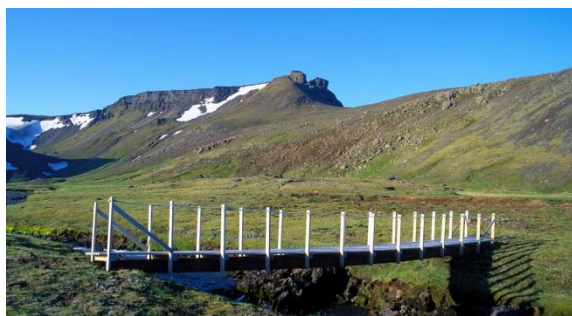
Mynd 6-3 Göngubrú yfir Móðulæk í Eysteinsdal.
