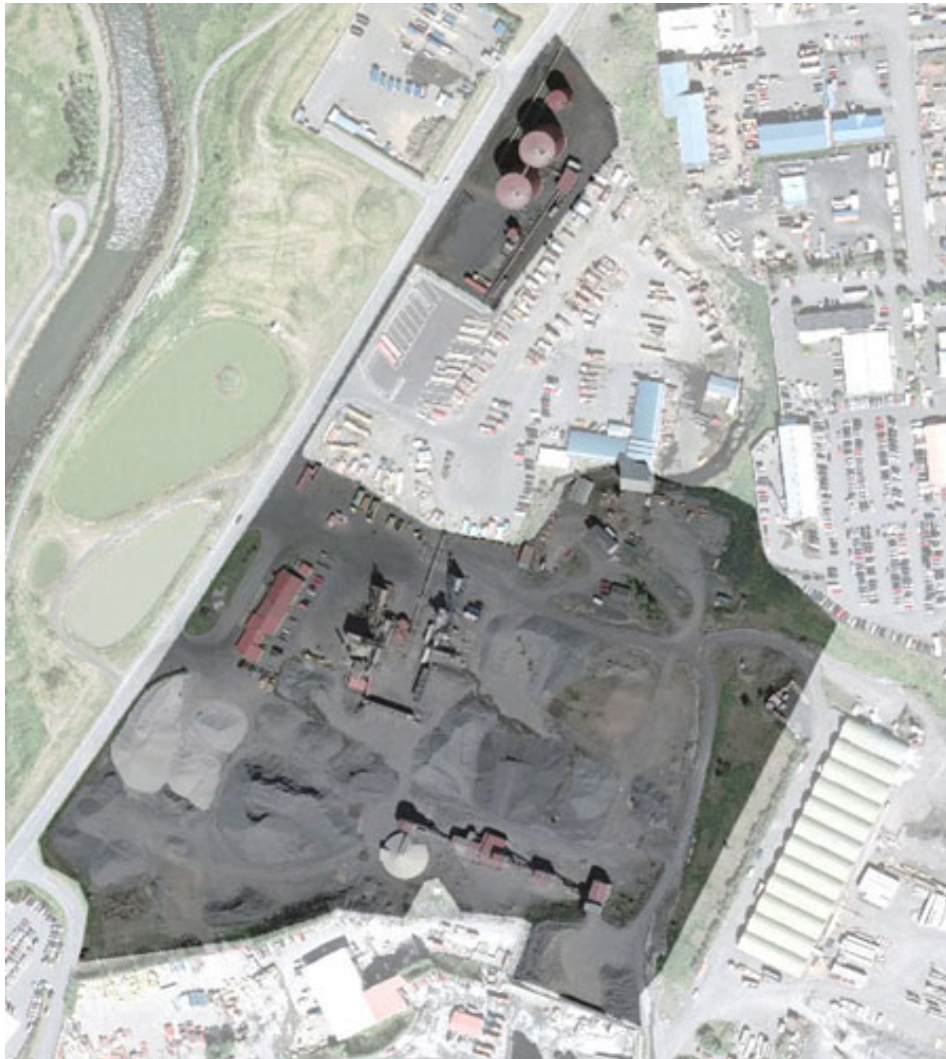
Mynd 1. Yfirlitsmynd af athafnasvæði fyrirtækisins við Sævarhöfða 6-10.
