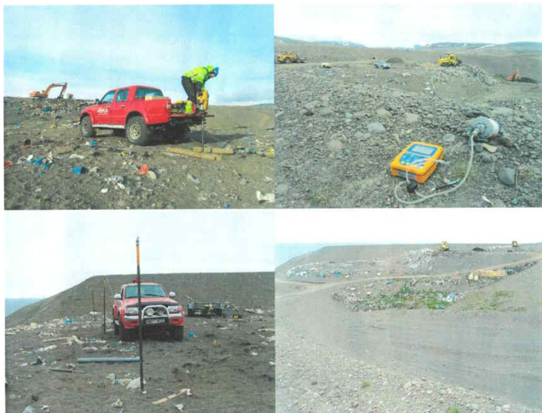
Mynd 2: Niðursetning gasmæliróra og gasmælingar á Stekkjarvík.
