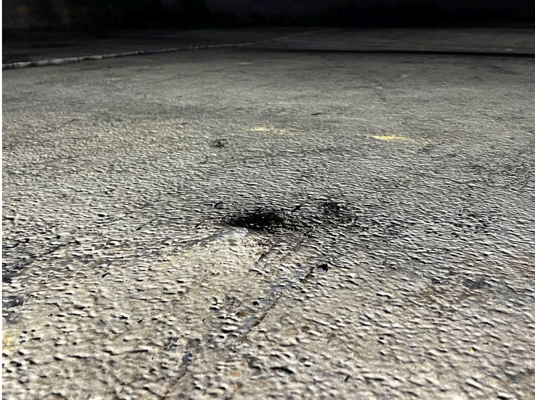
Mynd 3. Þúst er í plötu 12. Gólf hefur tærst en slíkt stöðvað með sandblæstri og málningu.
