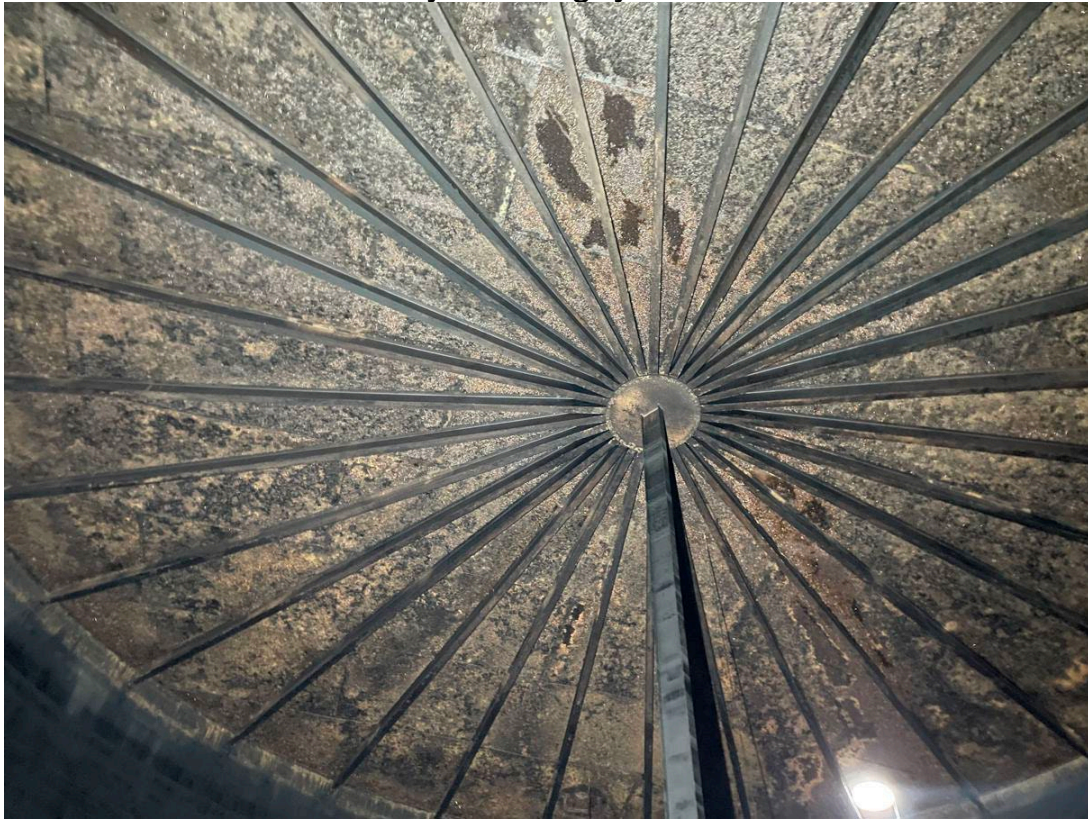
Mynd 1. Þak Geymis
