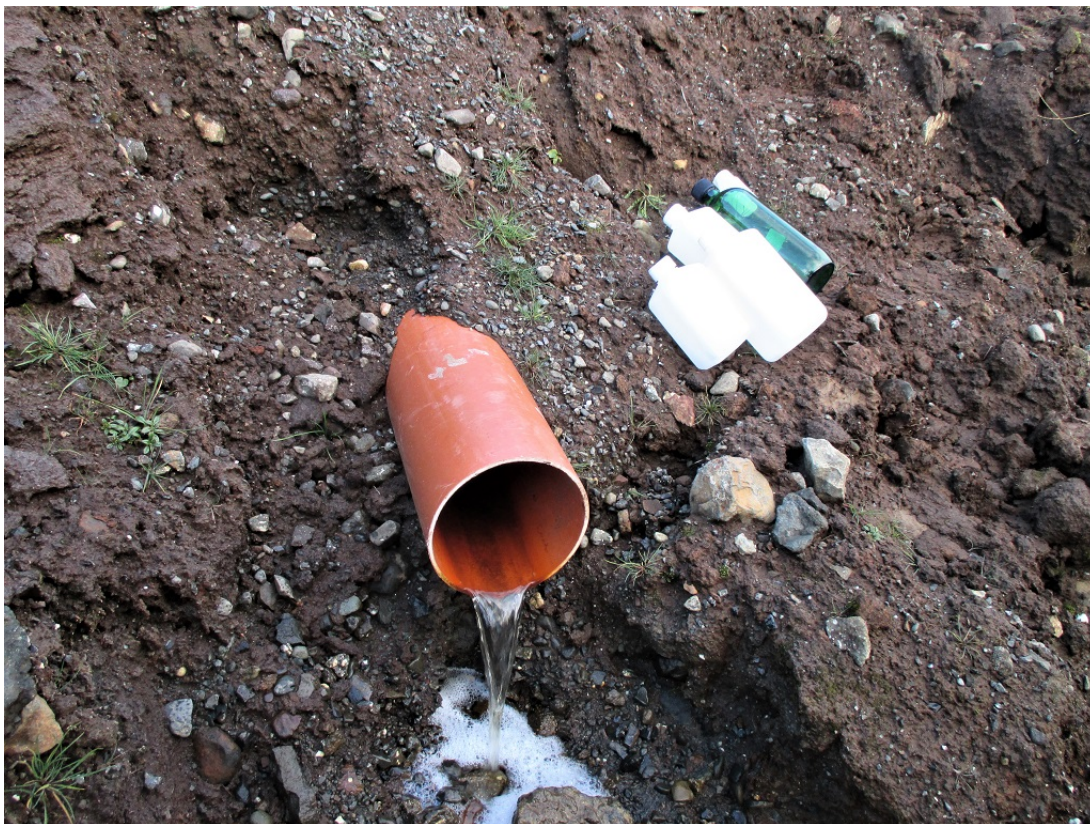
Mynd 7. Rennsli úr yfirfalli hreinsikerfisins í Fíflholtum 2. október 2018 (0,22 l/sek). (Ljósm. S.G.).
