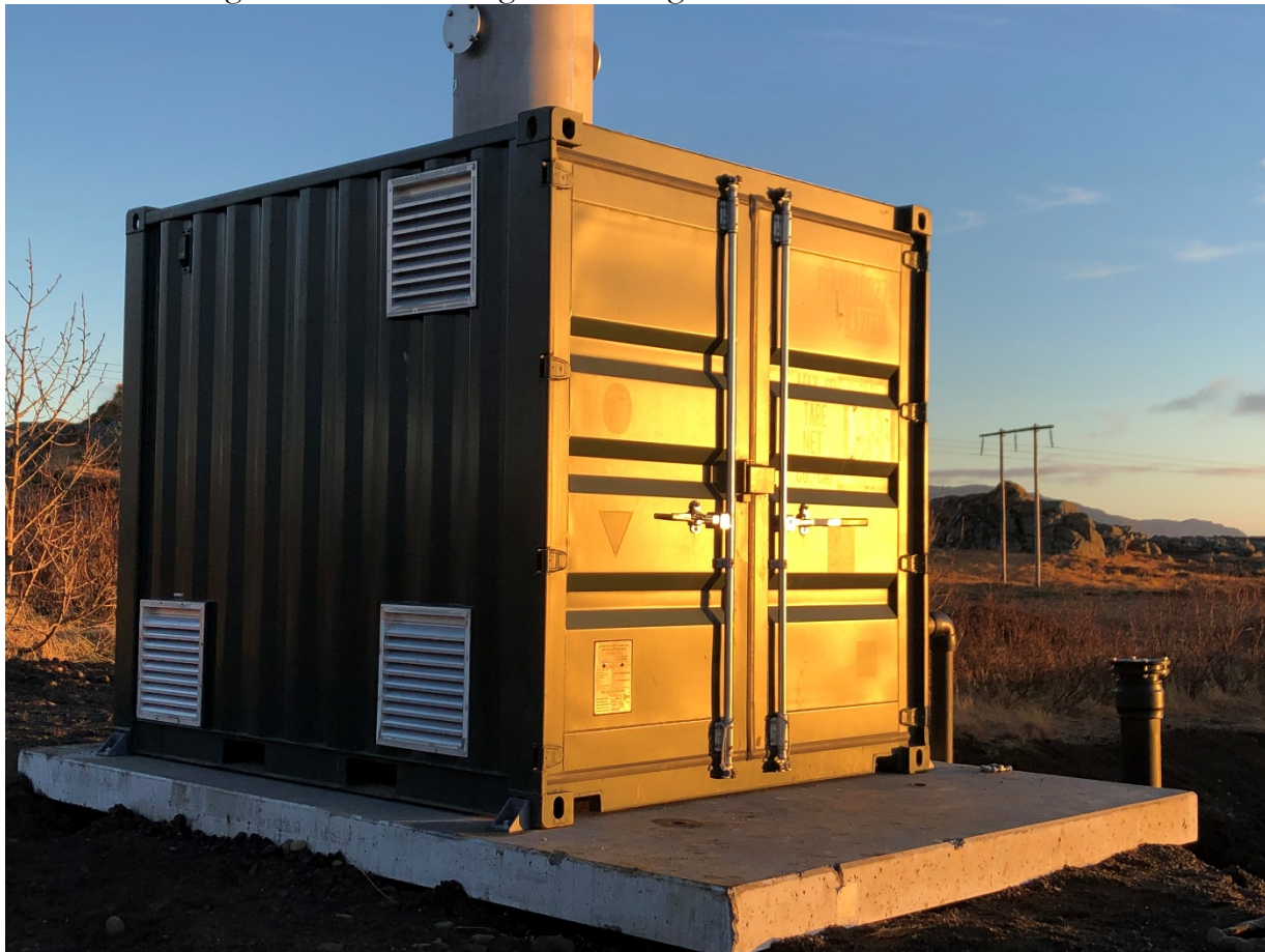
Mynd 5. Brennari metangass /kyndill, komin á sinn stað haustið 2018. Ljós. HBJ.
