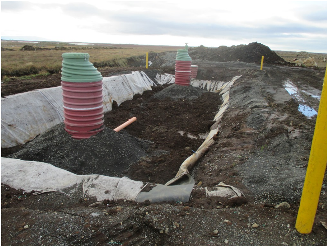
Mynd 2. Horft suður yfir síðubeðið. Tengingar komnar á sinn stað er eftir að ganga frá yfirborði. (Ljósm. S.G. 28. sept. 2017).
