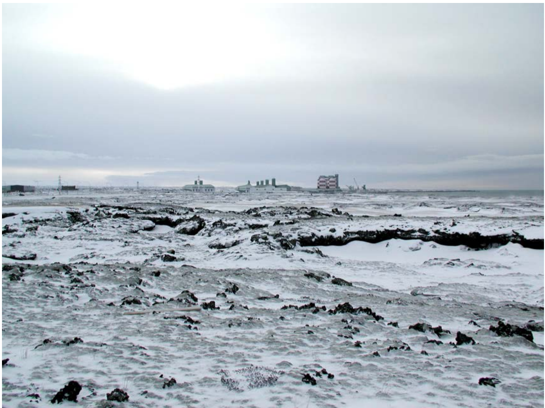
Mynd 20.8 Ljósmynd af álveri ISAL og fyrirhugaðri stækkun þess, séð frá Byggðarbraut (staður 3 á yfirlitsmynd), neðst á Hvaleyrarholti.
