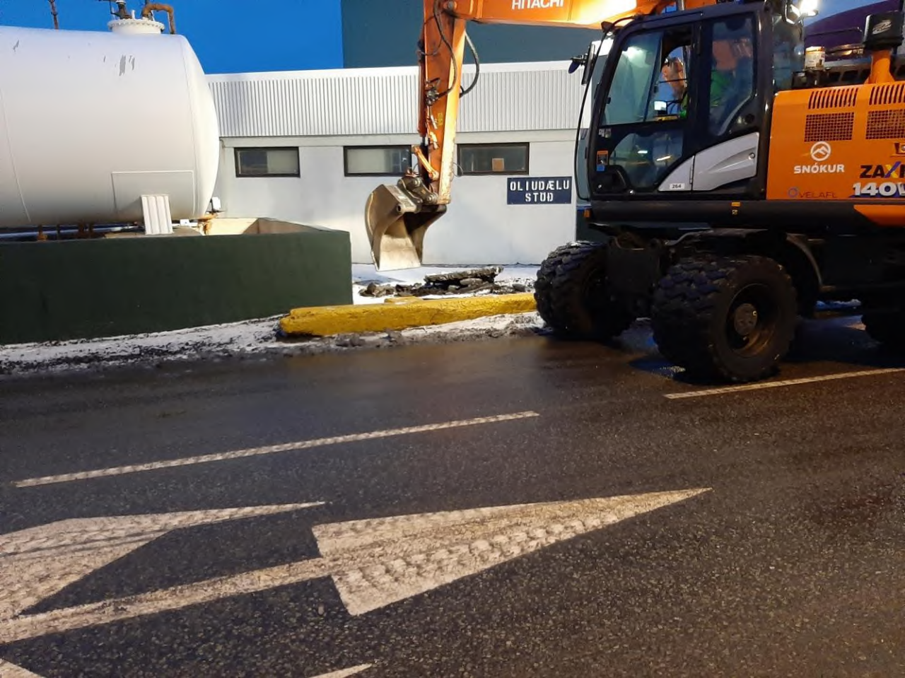
Dæmi um sýnatöku Sýni 5 - Milli gasolíutanks og olíudælustöðvar.
