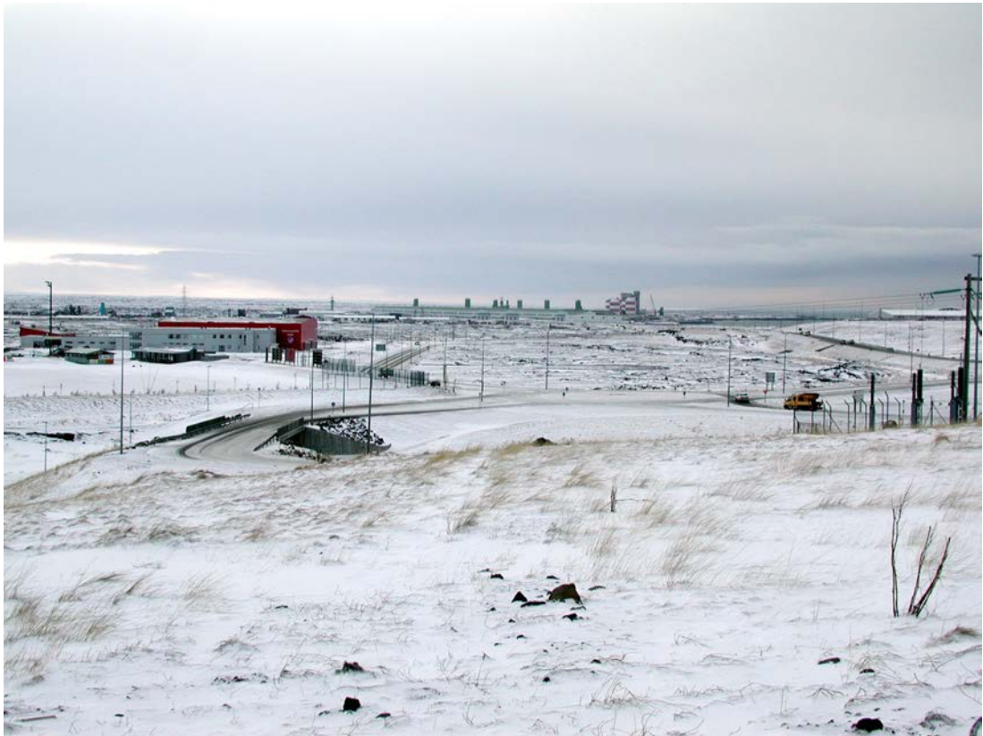
Mynd 20.10 Ljósmynd af álveri ISAL og fyrirhugaðri stækkun þess, séð frá Blikaási (staður 4 á yfirlitsmynd), vestast í Áslandi, austan Reykjanesbrautar.
